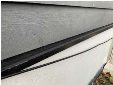
Tett for lufting i nedkant av kledning
