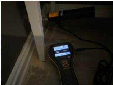
Fuktmåling i vegg ved hulltaking.
