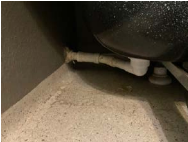
Badekar har avløp ført ut på yttervegg
