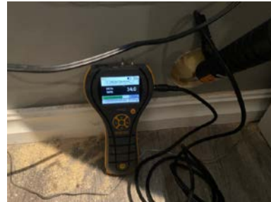
Fuktmåling i vegg under bakkenivå
