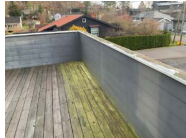
Rekkverk og gulv med grønske og malingsflass
