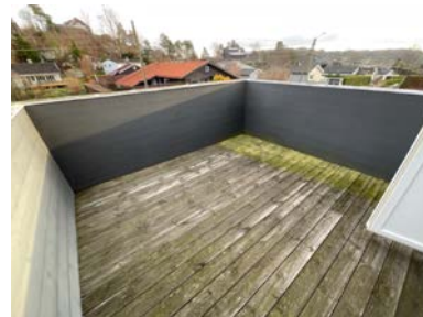
Rekkverk og gulv med grønske og malingsflass
