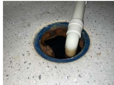
Eldre stålsluk i gulv.
