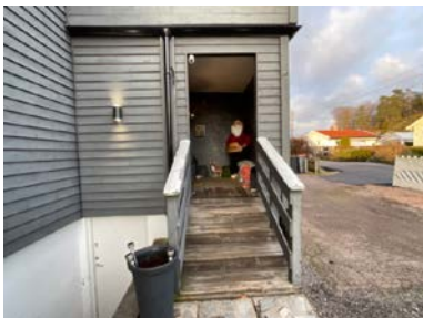
Trapp i fbm. inngangsparti.
