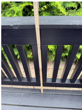
Rekkverkshøyde ved inngangsparti
