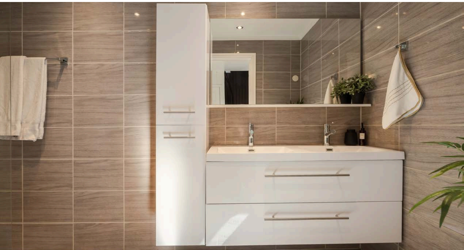
Badet i 1. etasje er pusset opp i 2014 med flislagte gulv og vegger i samme stil. I gulvet er det elektriske varmekabler.
