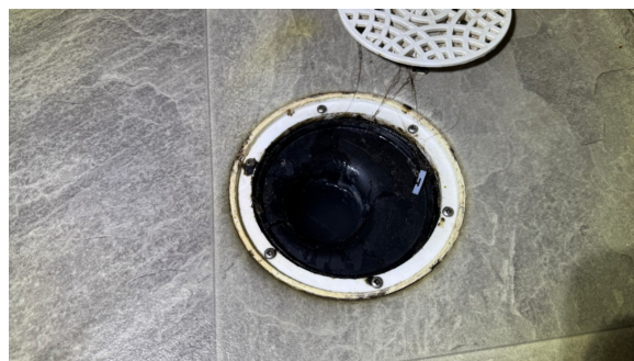
Kontroll av sluk i dusjsone.
