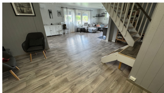
Største målte planavvik er målt i stuen.
