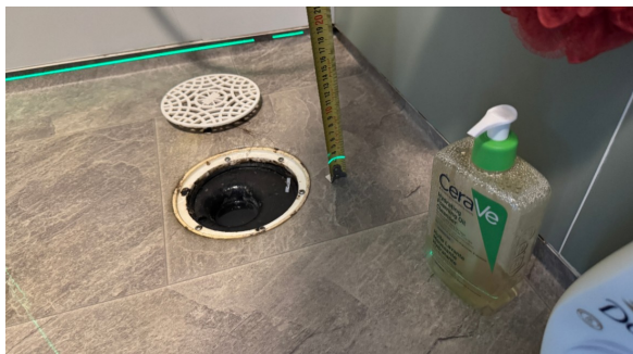
Kontroll av fallforhold.
