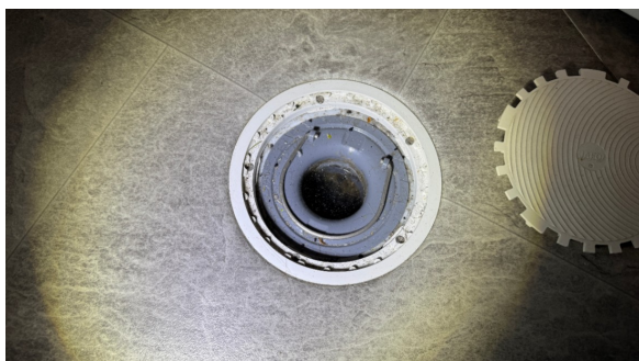
Kontroll av sluk.
