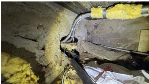
Deler av kryp kjelleren har begrenset inspeksjonsmuligheter, kun gjennom et lite hull i grunnmuren.
