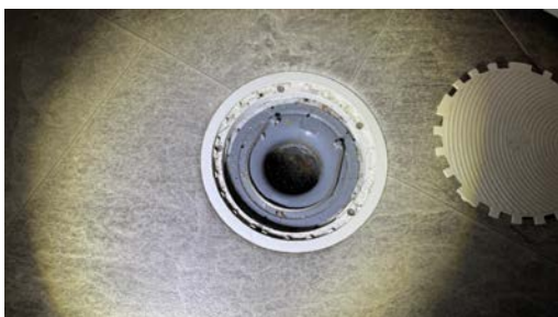
Kontroll av sluk.
