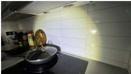
Ufagmessig montering av kjøkkenplater.
