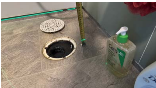
Kontroll av fallforhold.
