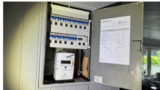
Kontroll av el-skap og kursfortegnelse.
