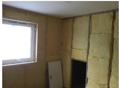
Et rom i kjelleren under oppussing
