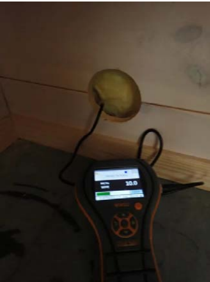
Fuktmåling viser at det er tørt inne i vegg ved hulltaking mot våtrommet.
