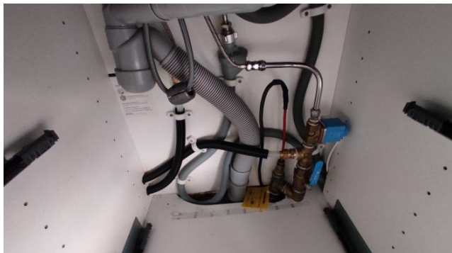
Kontroll av røropplegg.
