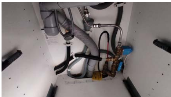
Kontroll av røropplegg.
