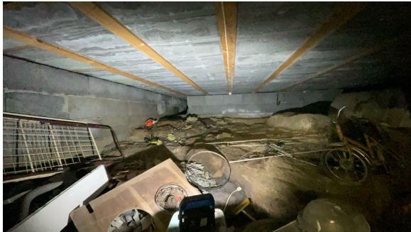
Etasjeskiller med trebord og Eternitplater.
