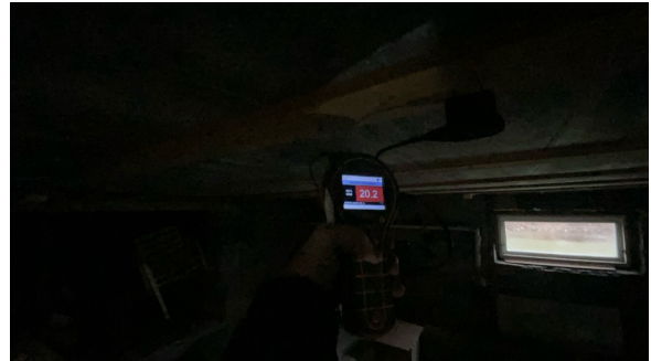
Fuktmåling i trebord under etasjeskiller.
