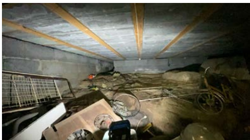
Etasjeskiller med trebord og Eternitplater.
