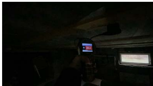
Fuktmåling i trebord under etasjeskiller.
