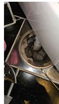
Det registreres sluk fra byggeår, og ingen slukmansjett under klemring.
