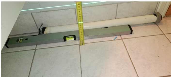
Kontroll av fall mot sluk.
