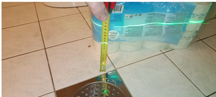
Kontroll av fall mot sluk.
