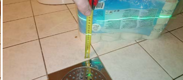
Kontroll av fall mot sluk.
