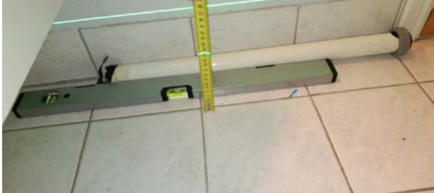
Kontroll av fall mot sluk.
