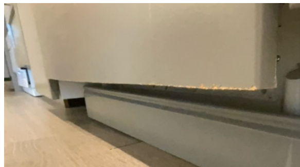
Punktskader på innredning.
