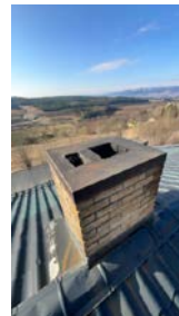
Pipe anbefales helbeslått over tak.
