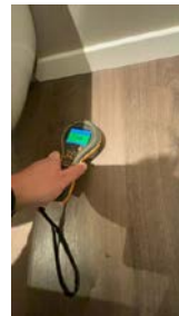
Ved bruk av fuktindikator på utsatte steder registrerte jeg ingen unormale verdier.
