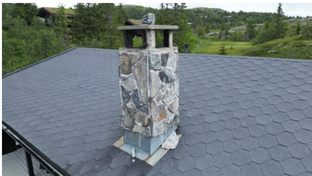
Pipe over tak som natursteinsforblendet.
