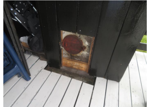
Sotluke etablert bak luke av utv. kledning.
