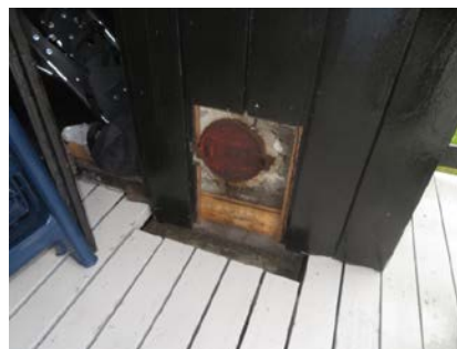
Sotluke etablert bak luke av utv. kledning.
