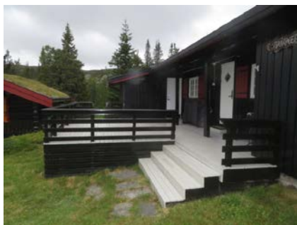
Nyere etablert markterrasse ut for og i forbindelse med inngangspartiet.
