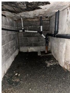
Bod under tilbygg med singel/grus på gulv.
