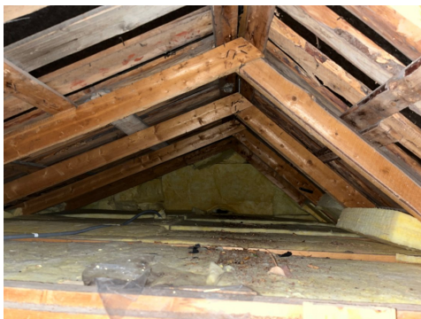
Møneloft uten ventiler.
