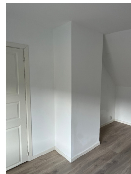
Pipe loftetasje er kledd igjen med malte plater.
