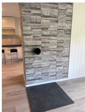
Plass til ildsted med åpent røykrør.
