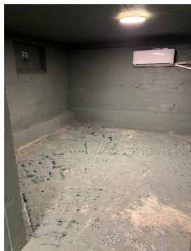
Overflater i kjeller er behandlet og montert varmepumpe.
