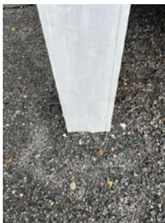
Søylefundament er ført ned i grunn.
