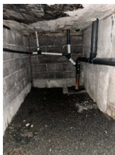
Bod under tilbygg med singel/grus på gulv.
