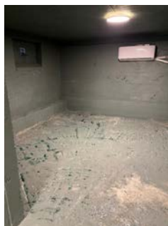
Overflater i kjeller er behandlet og montert varmepumpe.
