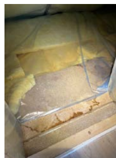
Fuktmerker på plate ved luke til kneloft.
