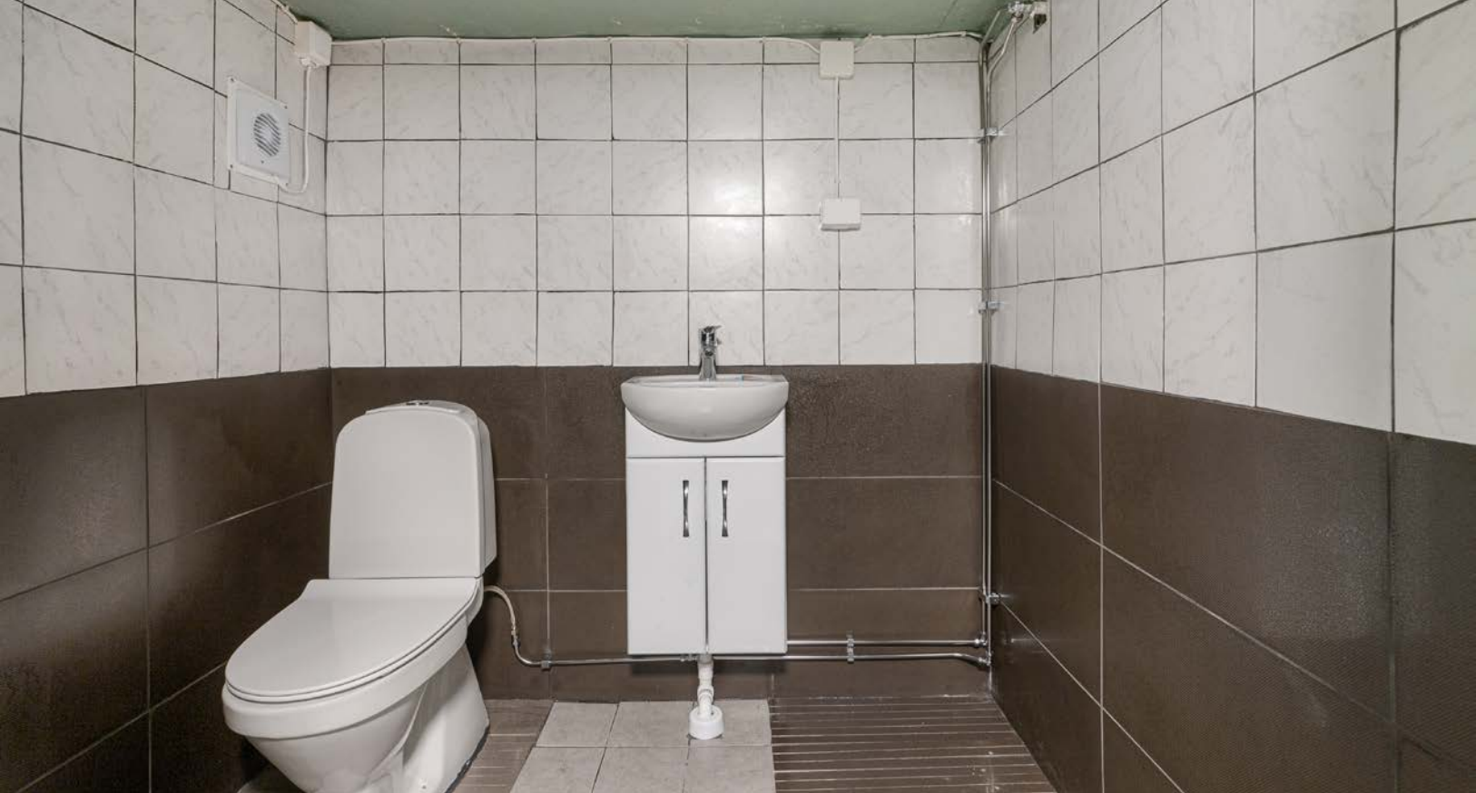
Toalettrom i kjelleretasje med fliser på gulv og vegger, og støpt himling. Rommet er utstyrt med frittstående toalett, servant og elektrisk avtrekksvifte.
