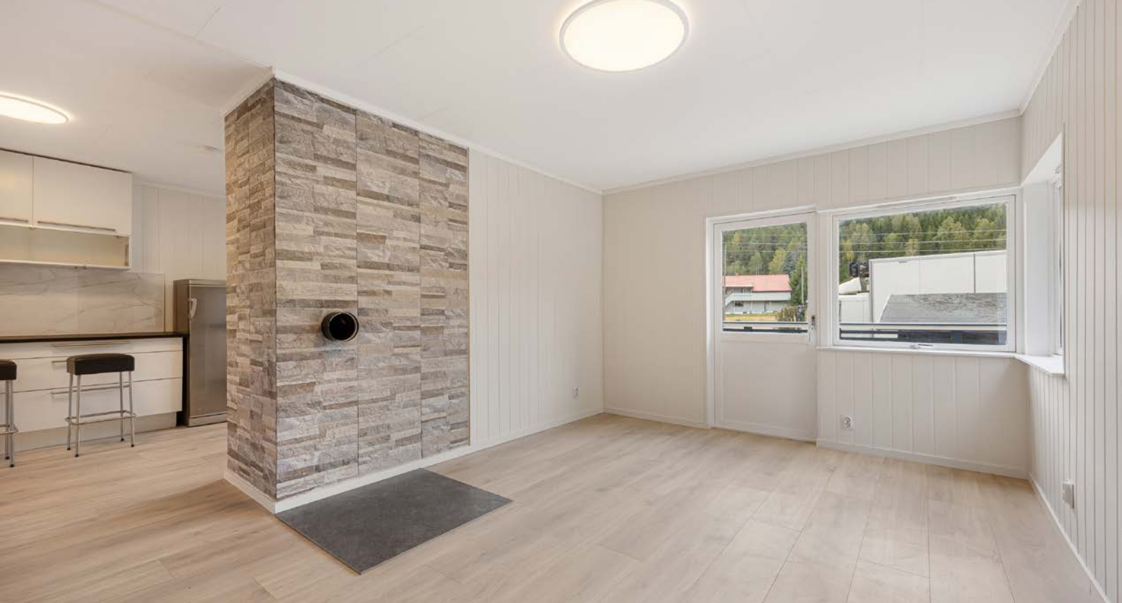
Teglsteinspipen mellom kjøkken og stue forblendet med steinplater og det er mulighet for tilkobling av ildsted.
