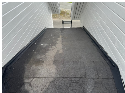
Taktekkingen over inngangspartiet.
