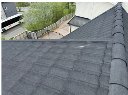
Eksempel på bulk i takplate.
