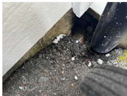
Takrennenedløp avsluttet ved grunnmuren.
