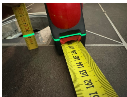
Måling ved sluken.
