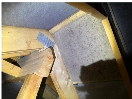
Svertesopp på takplate.
