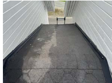
Taktekkingen over inngangspartiet.
