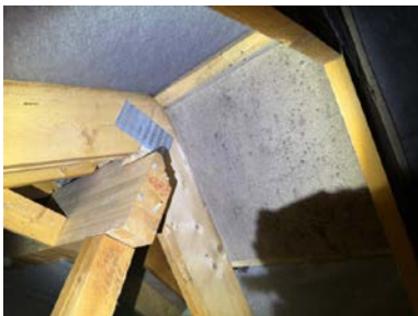
Svertesopp på takplate.
