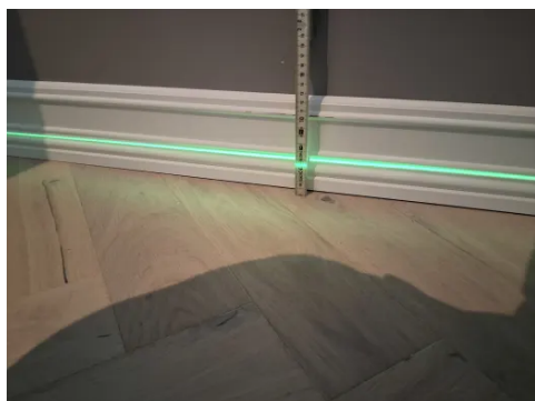
Etasjeskillet er kontrollert med nivelleringslaser.
