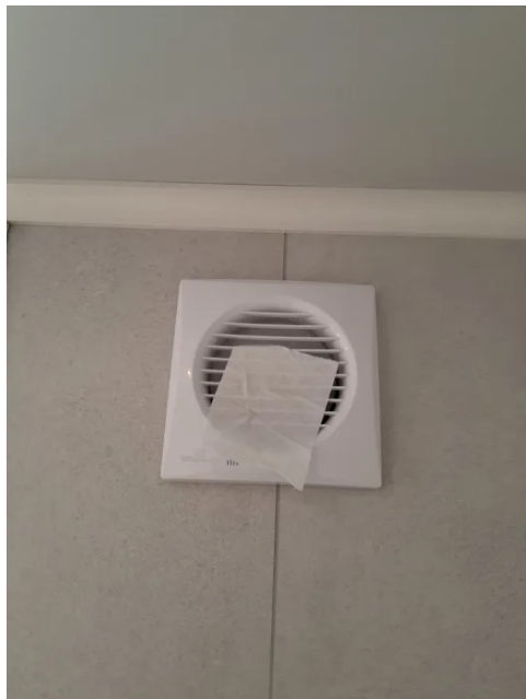
Avtrekkeseffekten er testet med papir.
