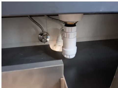
Leiligheten har synlige avløpsrør av plast.
