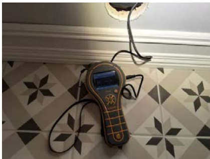
Bilde fra fuktmåling i veggkonstruksjon tilstøtende dusjsone.
