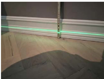
Etasjeskillet er kontrollert med nivelleringslaser.
