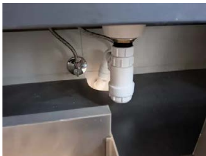
Leiligheten har synlige avløpsrør av plast.
