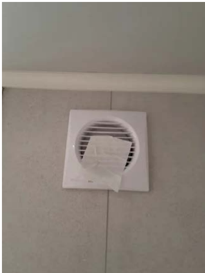
Avtrekkeseffekten er testet med papir.
