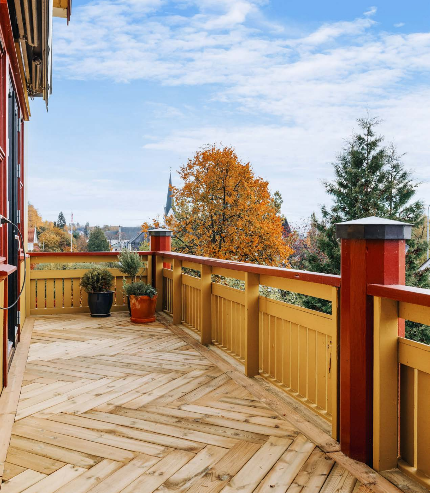
Til og med terrassegulvet er lagt i fiskebeinsmønster.
