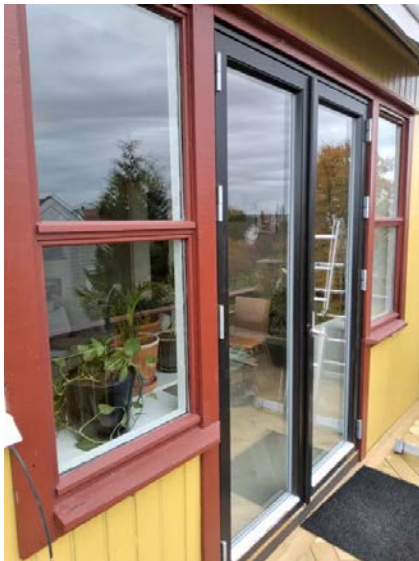
Hovedparten av vinduer i leiligheten har vinduer fra 1987.
