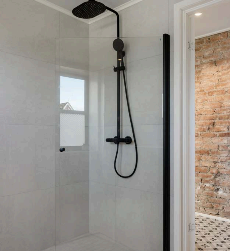
Dusjhjørne med innfellbar dusjdør og vegghengt dusjbatteri med regnfall.
