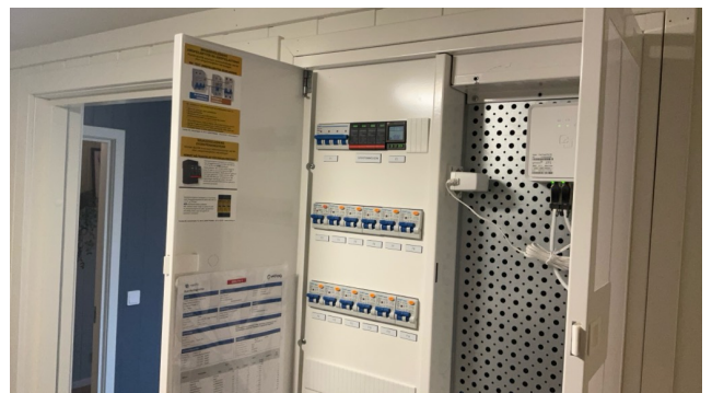
Sikringsskap med kursfortegnelse i samsvar med antall sikringer.
