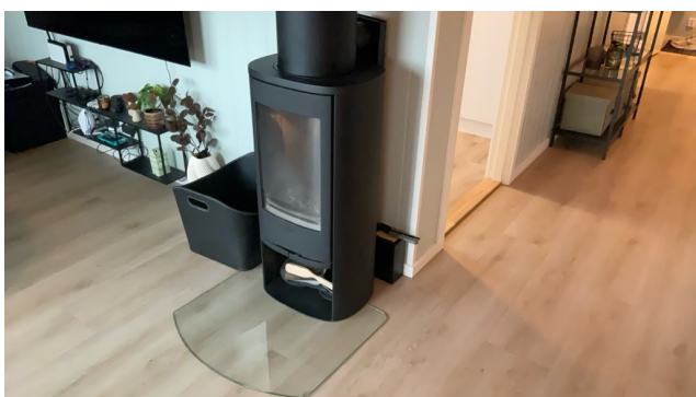
Ildsted med stålpipe.
