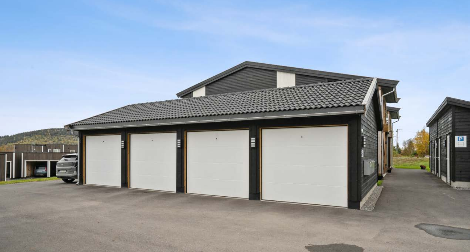
Garasje i rekke. Det er gjesteparkering på venstre side.
