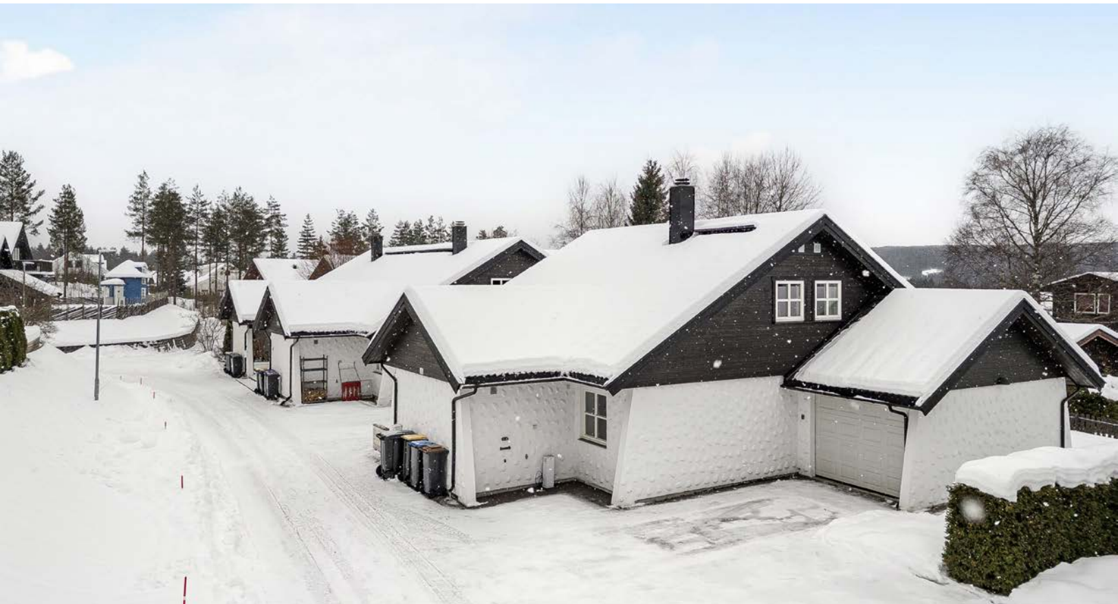
Boligen har inntilbygget garasje på 16m 2 . Garasjen har leddport med motorstyring og lys.
