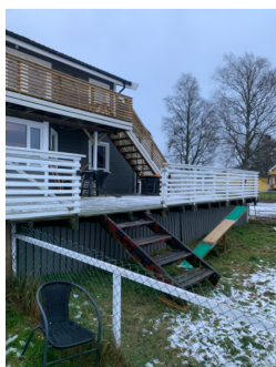
Det mangler rekkverk i forbindelse med trapp
