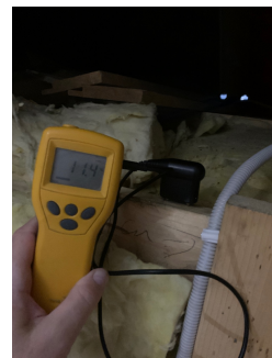
Ingen fukt målt i undergurt bjelker
