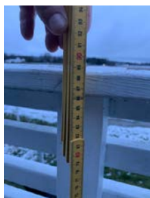
Det mangler rekkverk i forbindelse med trapp
