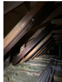
Konstruksjon og utførelse er fagmessig
