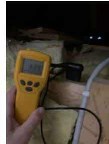
Ingen fukt målt i undergurt bjelker
