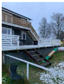
Det mangler rekkverk i forbindelse med trapp
