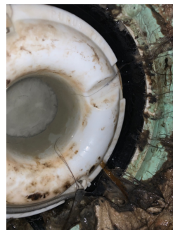
Det er ikke mulig å se membran i sluket
