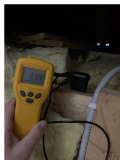
Ingen fukt målt i undergurt bjelker
