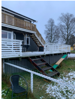
Det mangler rekkverk i forbindelse med trapp
