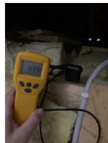
Ingen fukt målt i undergurt bjelker
