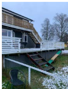
Det mangler rekkverk i forbindelse med trapp
