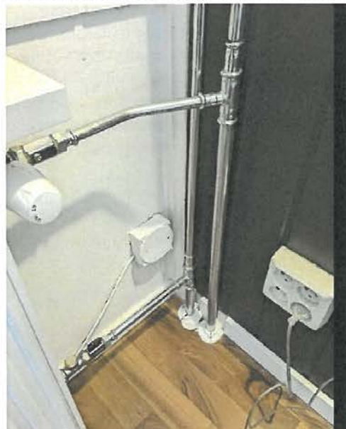
Bilde 2 – Løsning i Ortuvann Borettslag
