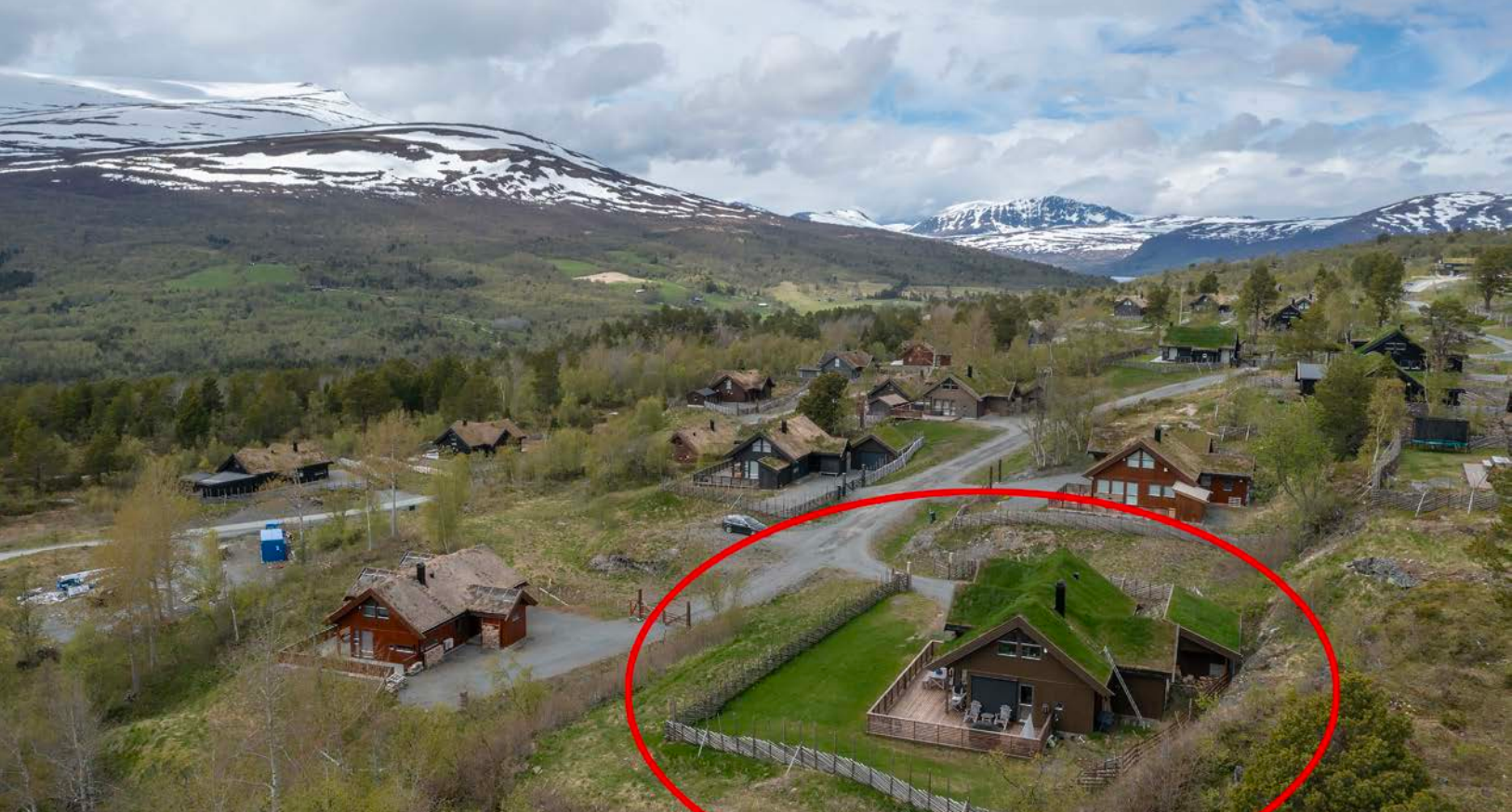
Oversiktsbilde med markering
