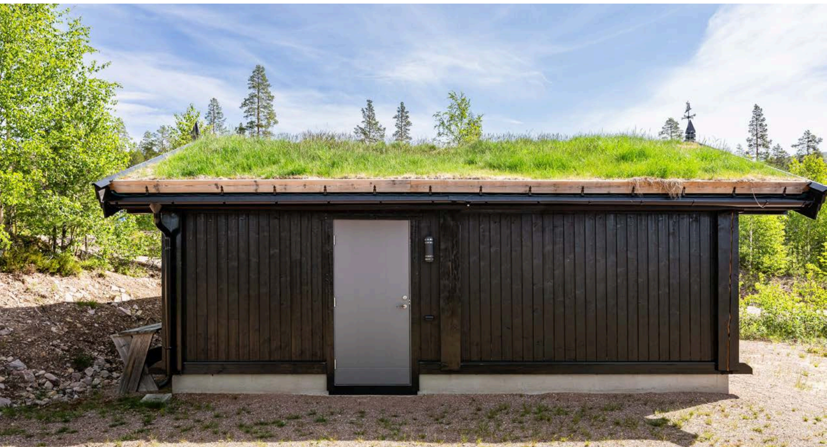
Garasje fra 2022 med yttervegger av stavlaft kledd med stående trekledning, saltak tekket med torv, garasjeport med portåpner og ytterdør.
