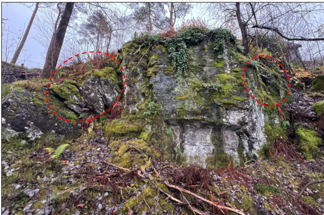
Figur 4: En skrent nord for eksisterende bolig i kartleggingsområdet. Enkelte potensielt sprekkeavgrensede bergblokker er angitt i rødt.
