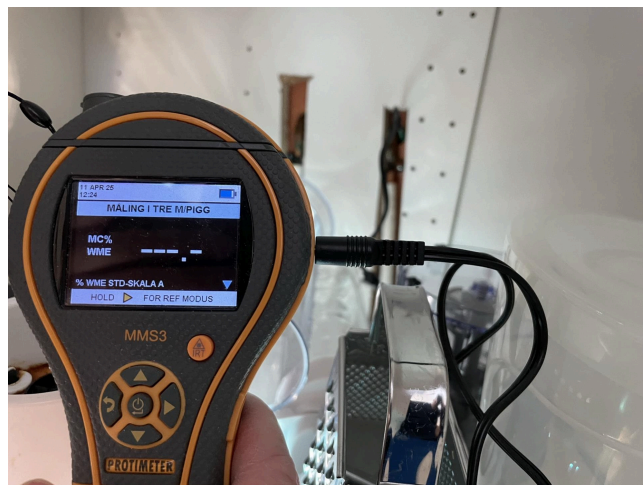
Kontroll av tiliggende konstruksjoner er utført ved hjelp av fuktindikator og hulltaking.
