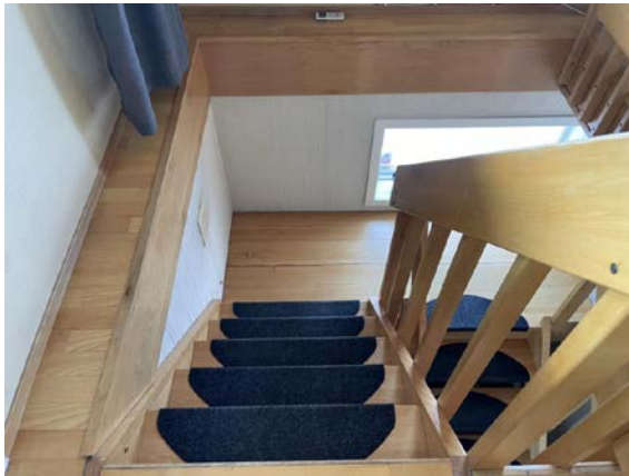
Manglende rekkverk.
