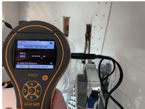
Kontroll av tilleggende konstruksjoner er utført ved hjelp av fuktindikator og hulltaking.
