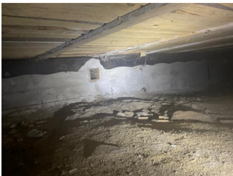
Ventiler i tørr krypkjeller
