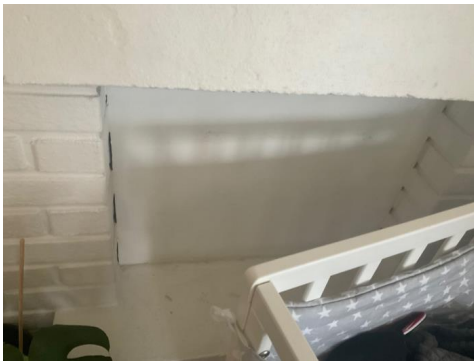
Peisen er forblendet med plate
