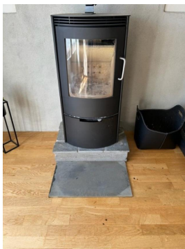
Peisen er forblendet med plate
