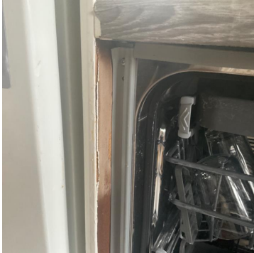
Liten delaminering på skap stamme ved oppvaskmaskin.
