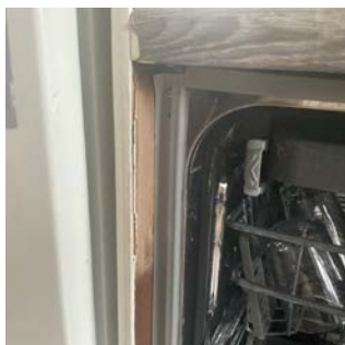
Liten delaminering på skap stamme ved oppvaskmaskin.
