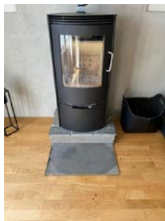
Peisen er forblendet med plate
