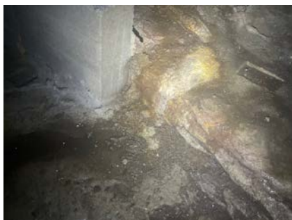
Tilsig av vann under grunnmur
