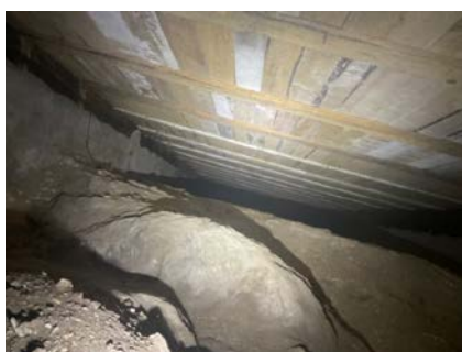
Tørt og fint i krypkjeller under stue/soverom
