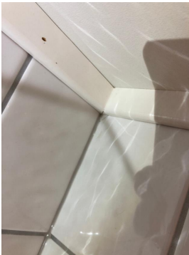
Bilde av knekt hjørne på veggflis
