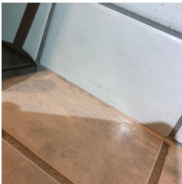
Bilde av knekt hjørne på veggflis
