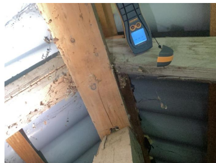
Ved enkel fuktmåling registrerte jeg tørre verdier.
