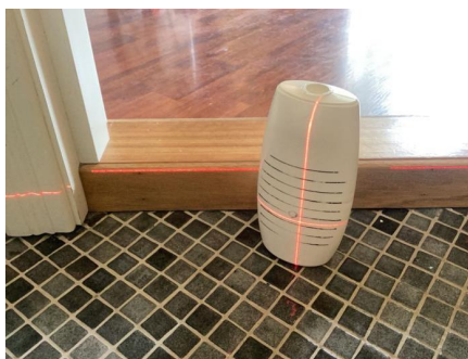
Høydeforskjell fra topp slukrist til topp gulv ved terskel ca 7 mm.
