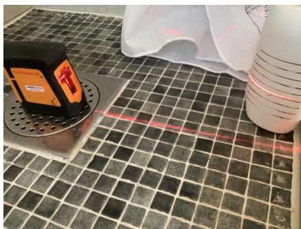
Flatt gulv i dusjsone.
