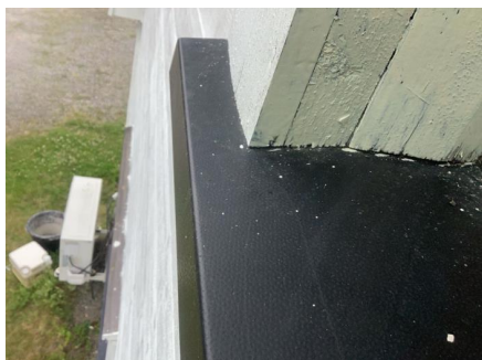
Ingen klaring mellom omramming og vannbrett, 5 - 6 mm er anbefalt.
