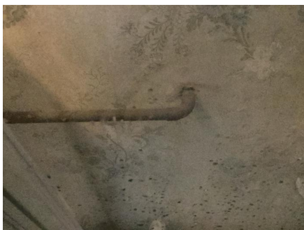
Rørgjennomføringer på vegg i dusjhjørne uten membran.
