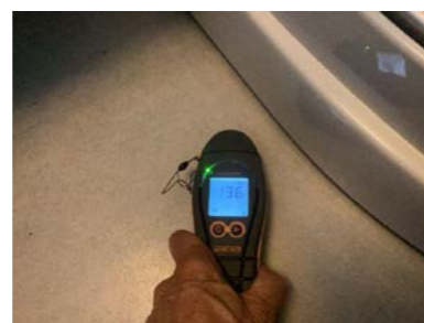
Ved enkle fuktsøk registrerte jeg ingen unormale verdier.
