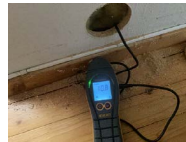
Ved fuktmåling ble det registrert tørre verdier (under 12%).
