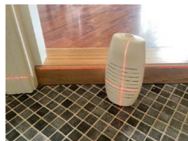
Høydeforskjell fra topp slukrist til topp gulv ved terskel ca 7 mm.
