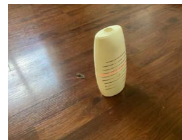
Kjøkken. Overflateavvik ca 18 mm.
