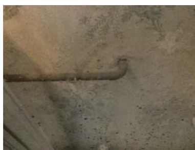
Rørgjennomføringer på vegg i dusjhjørne uten membran.
