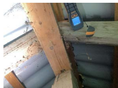
Ved enkel fuktmåling registrerte jeg tørre verdier.
