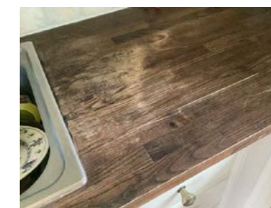
Slitasje skade på benkeplate.
