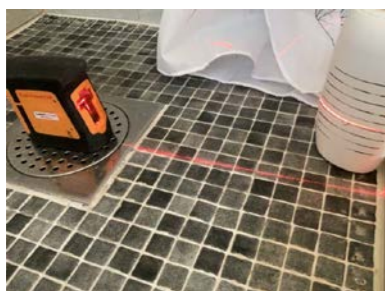
Flatt gulv i dusjsone.
