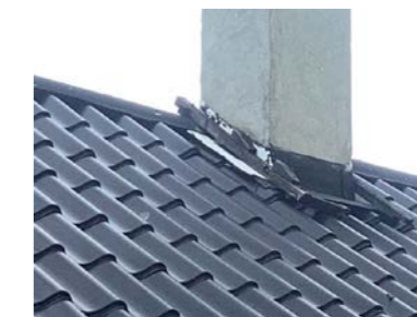
Folie eller malingsflask ble registrert. Pipehatt og mønebeslag.
