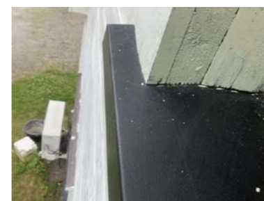
Ingen klaring mellom omramming og vannbrett, 5 - 6 mm er anbefalt.
