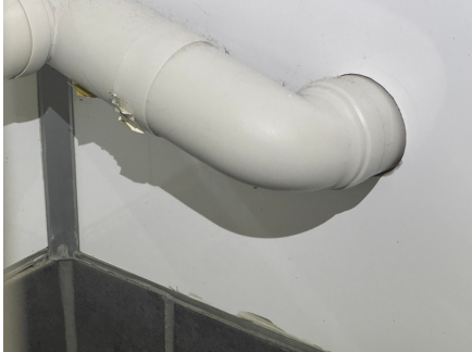
Utett rørgjennomføring.
