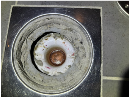
Utett rørgjennomføring.
