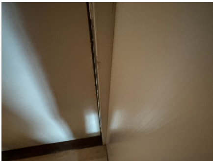
Utett mellom karm og pakning.
