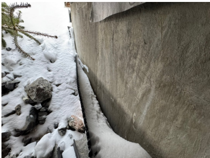
Det er ikke montert list eller beslag i toppen av knastepappen.
