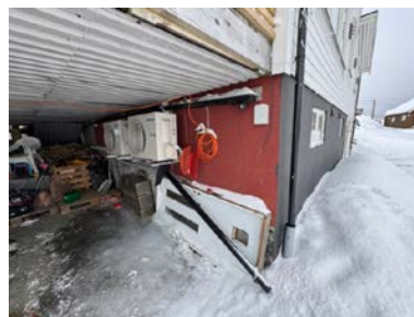
Eksempel på sprekkdannelse i grunnmuren.
