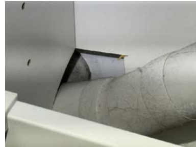
Utett rørgjennomføring.
