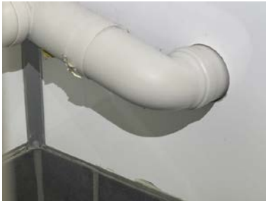
Utett rørgjennomføring.
