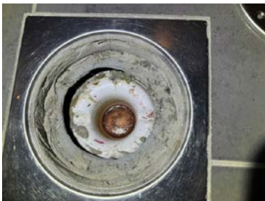
Utett rørgjennomføring.
