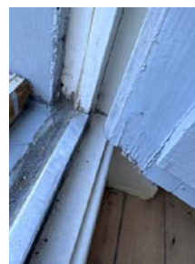
Bildet er tatt på befaringsdagen.
