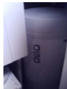
Bereder er plassert på teknisk rom/bod.
