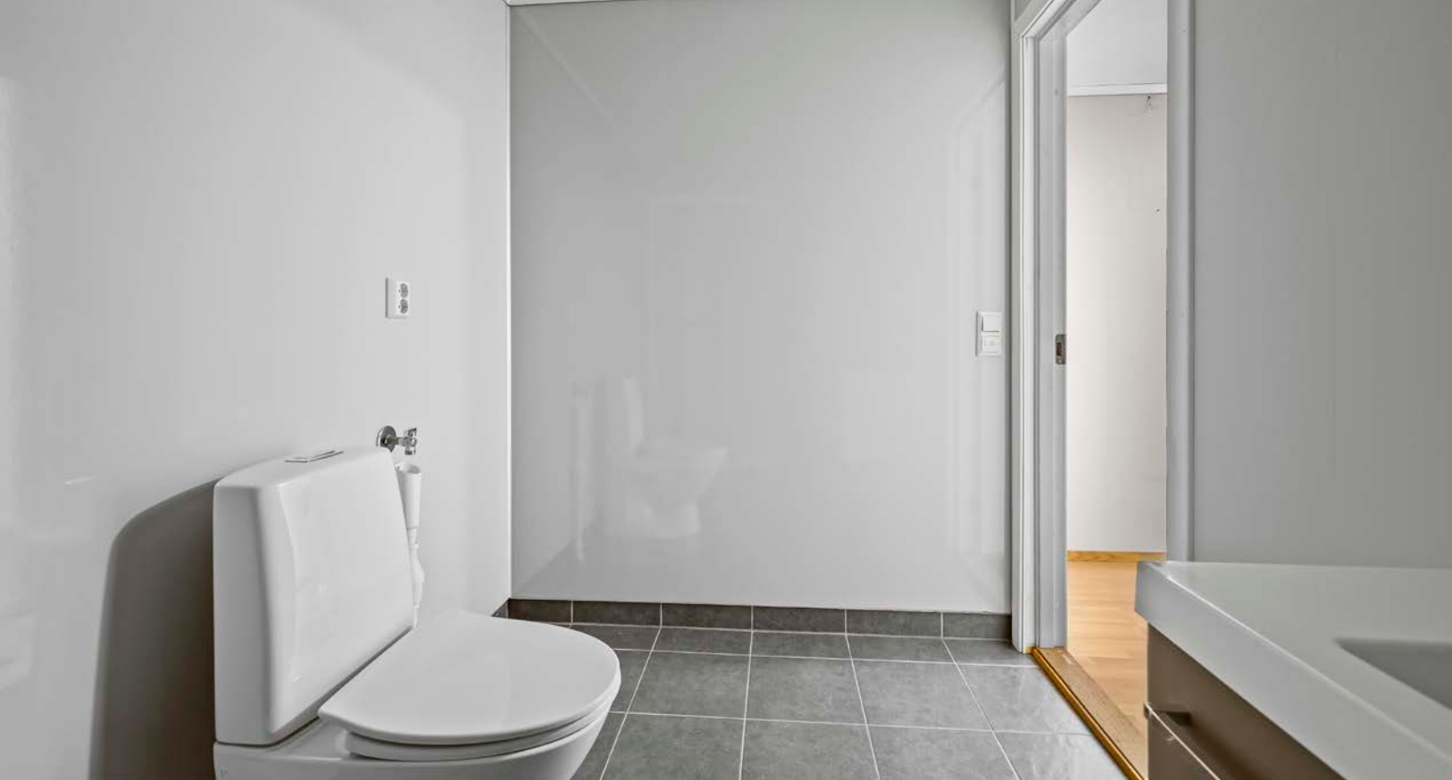
Bad med flislagt gulv med varmekabler og våtromsplater på vegg.
