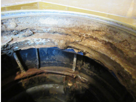
Synlig del av mansjett i sluk.
