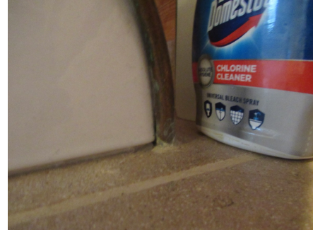
Ingen synlig membran i røropstikk til wc
