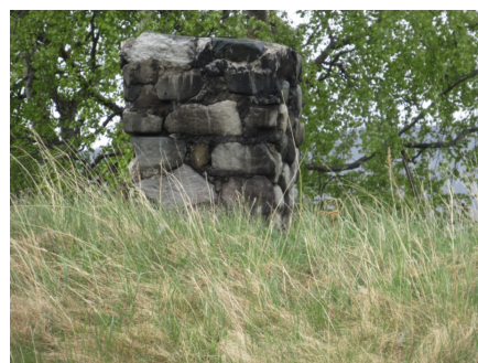
Pipe over tak tilbygg
